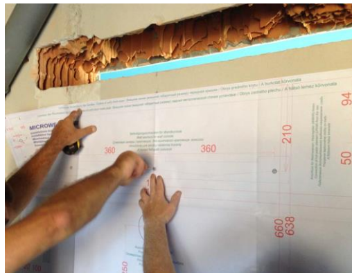
2. vyměření konzoly pomocí šablony
