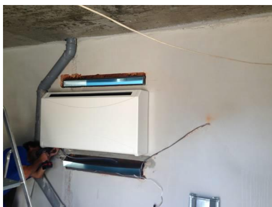
5. Namontování krytu odvlhčovače
