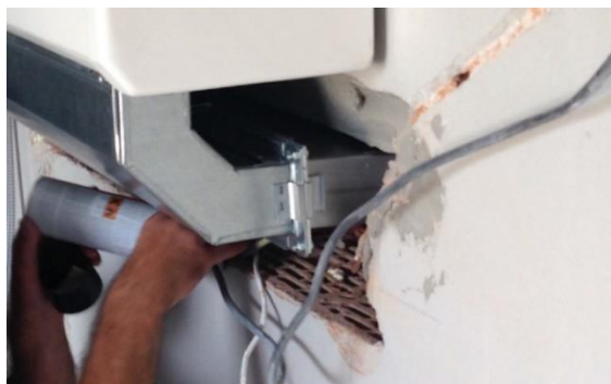
11. Vytěsnění mezer ve zdi PUR pěnou
