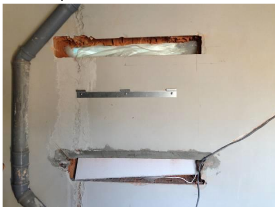
3. Namontování konzoly na stenu
