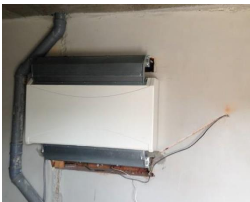
9. Namontování potrubí na kryt 10. Namontování potrubí zároveň s finálním povrchem stěny v bazénové hale
