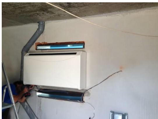
5. Namontování krytu odvlhčovače
