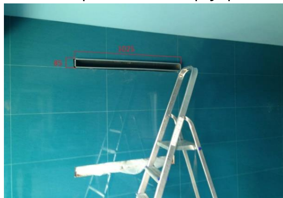
9. Namontování potrubí na kryt 10. Namontování potrubí zároveň s finálním povrchem stěny v bazénové hale
